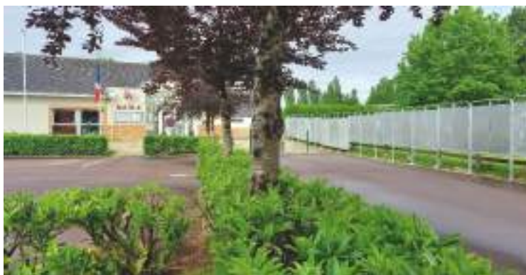
Mai 2024 : Aménagement de supports scellés pour les panneaux électoraux
