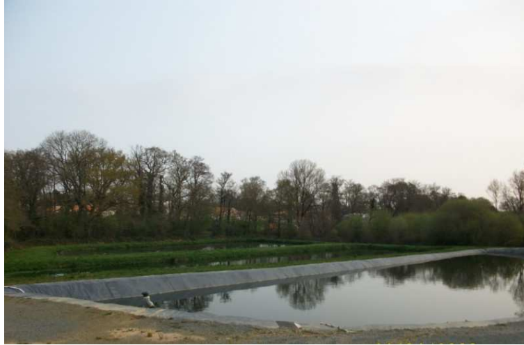
Bassins de décantation et stations d'épuration
