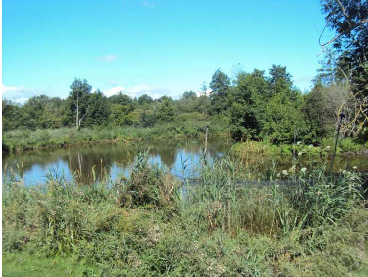
Lagunes industrielles et bassins ornementaux
