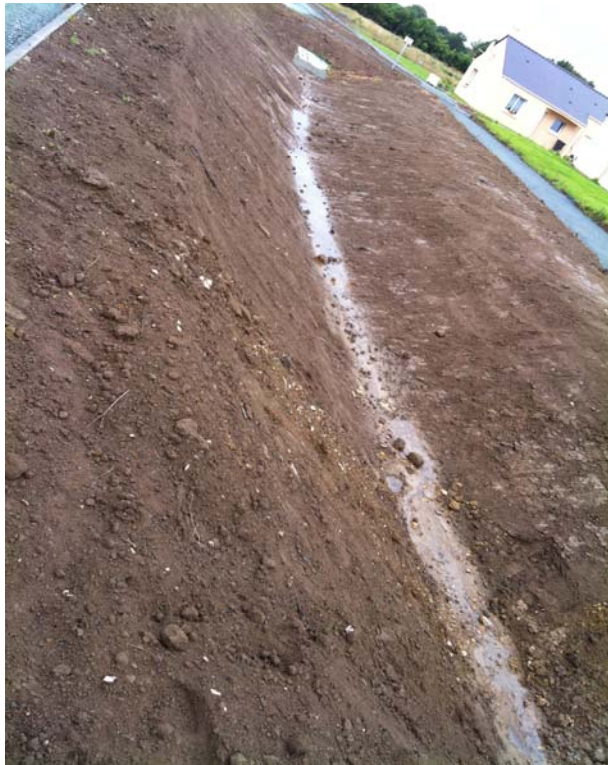
Vue d'ensemble du bassin de rétention
