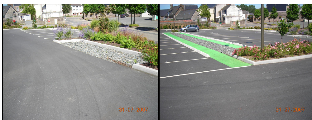
Photo 4 : Exemple de tranchées drainantes
