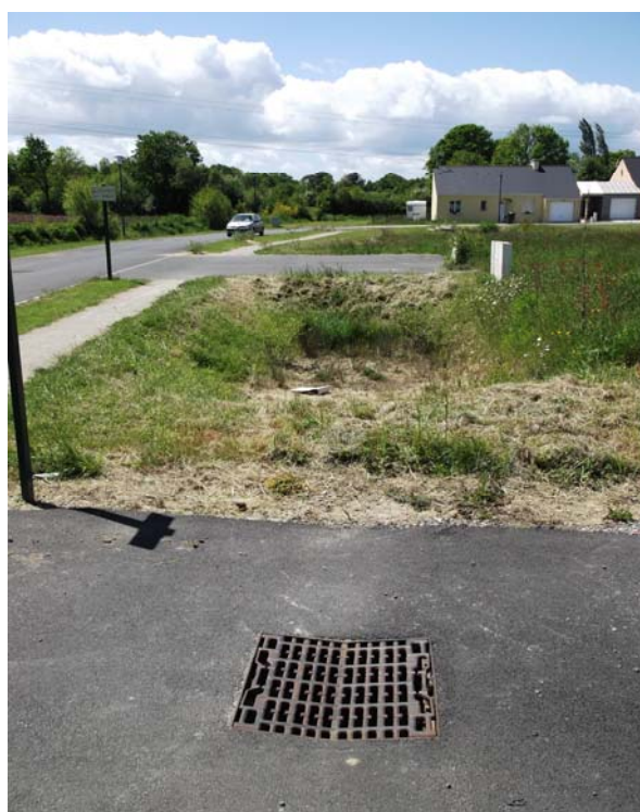
Vue du petit bassin en amont raccordé au grand par un Ø300
