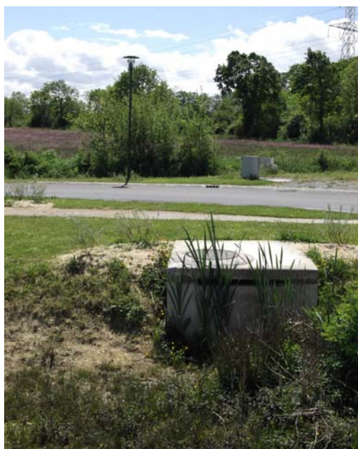
Vue de l'ouvrage de régulation
