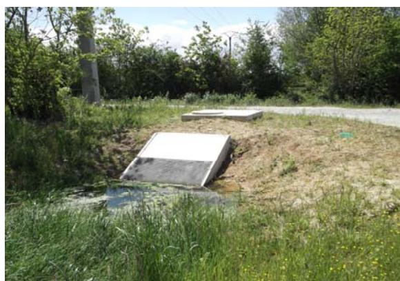
Vue de l'ouvrage de régulation
