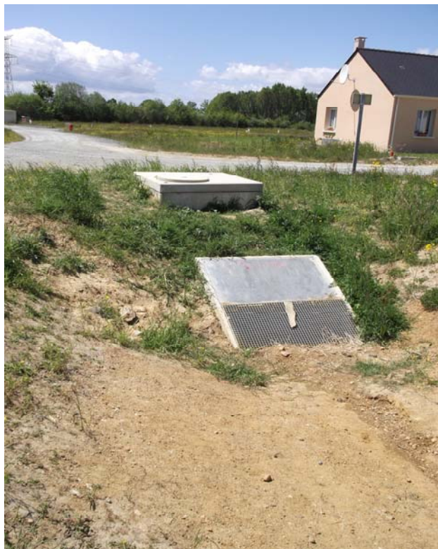
Vue de l'ouvrage de régulation
