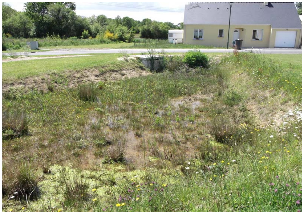
Vue d'ensemble du bassin de rétention
