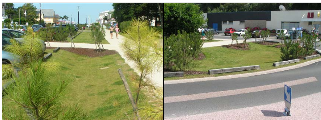
Photo 3 : Exemple de réalisation de noues paysagères
