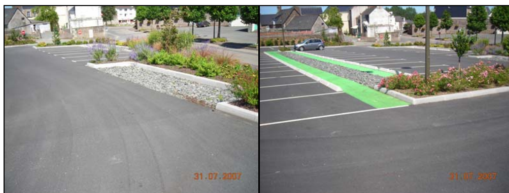
Photo 4 : Exemple de tranchées drainantes
