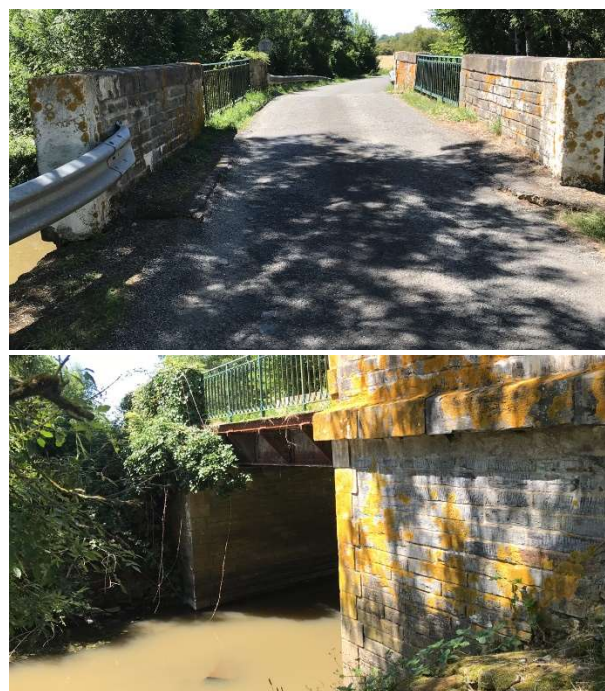
Photographie de l'ouvrage
